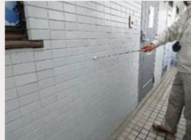
「外部(外壁)」調査の様子
