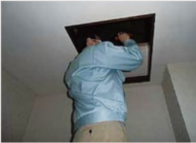
「小屋組・梁」調査の様子
