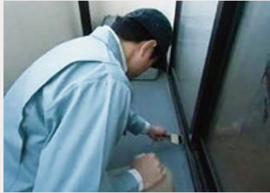
「外部(バルコニー)」調査の様子
