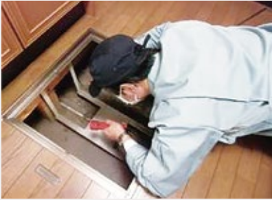
「土台・床組、基礎」調査の様子
