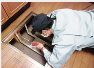
「土台・床組、基礎」調査の様子
