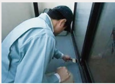
「外部(バルコニー)」調査の様子
