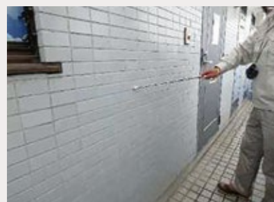
「外部(外壁)」調査の様子
