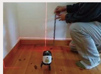
「床の傾きを計測する」調査機器
