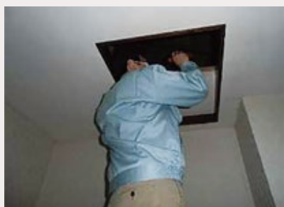
「小屋組・梁」調査の様子
